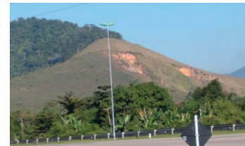
Figura 12: Processo erosivo em estágio avançado em área de pastagem.
